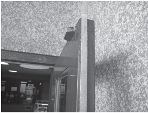
写真 14 締切ドアの処置
